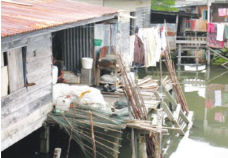
Gambar 3: Pelantar Rumah Wanita Bajau Yang Digunakan Bagi Pelbagai Tujuan
